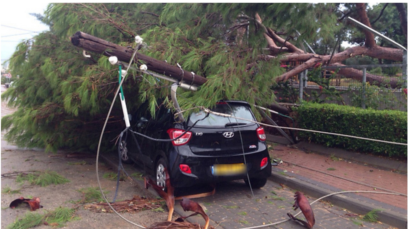
Red eléctrica dañada en 2015 (Zeev Botzer)
