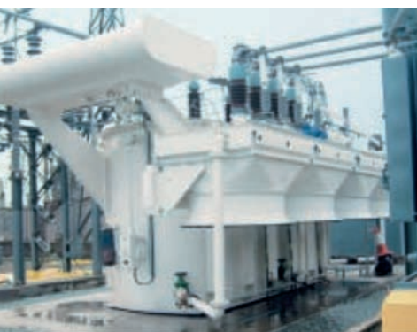
Figura 2 El transformador en (1) se reconstruyó para dejarlo en un estado totalmente funcional.
