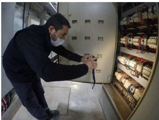
Personal evaluando comportamiento térmico con cámara termográfica.
