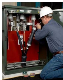
Figura 6 Conexión de motores en MT
