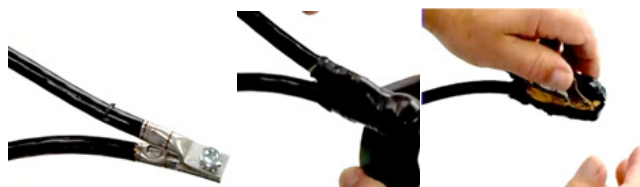
1 2 3 Figura 3 Un buen método de aislamiento de conexiones permite un fácil retiro futuro
