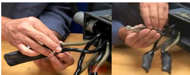
Motor con cables de salida
