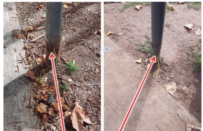
Columnas con conductores de protección no protegidos del hurto o del vandalismo y por ello expuestas a quedar sin conexión a tierra.
