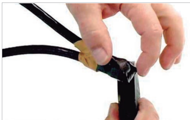
Figura 3. Un buen método de aislamiento de conexiones permite un fácil retiro.
