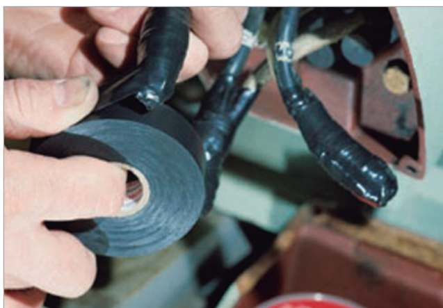
Figura 5. Acabado final del método recomendado en la Tabla 1 para motor de BT.
