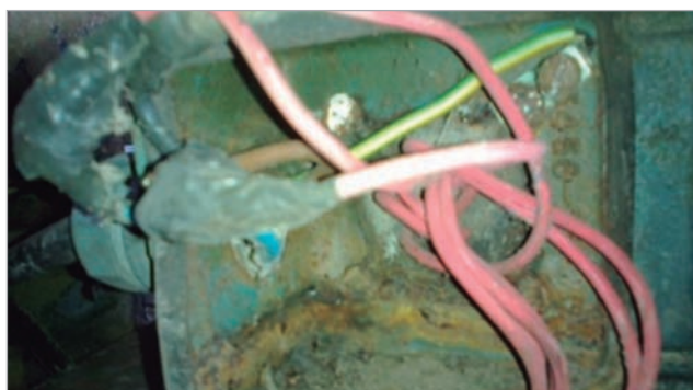
Figura. 1 Daño típico encontrado en la conexión de motores de BT.
