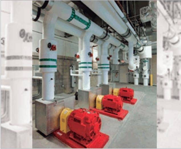
Figura 1. Disposición de las bombas del chiller.
