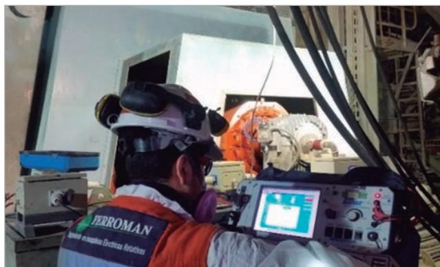
Figura 3. Ensayos dieléctricos durante la puesta en marcha de un motor (Cortesía de Ferroman S.A.-Chile)
